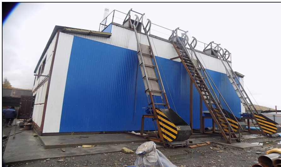
Рис. 9. Блочно-модульная котельная в п. Кропоткин
